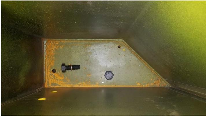
Monter 2 boulons 18x50 avec rondelle cuivre et ruban téflon dans le fond du réservoir, verrouiller fortement les 2 boulons pour éviter les fuites.
